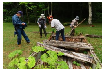
テント台の撤去作業
