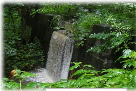
◆水量増した堰堤
